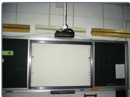
一般教室(整合施工)
